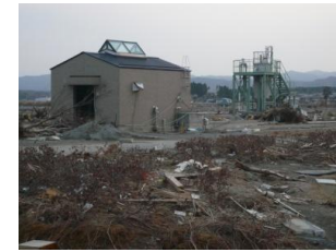
管理棟から見る被災状況
