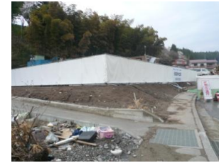
道路に面して処理用地確保
