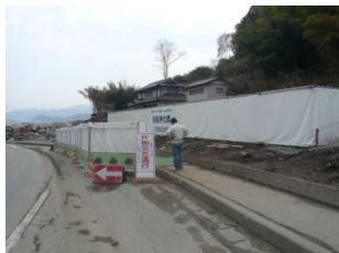
道路上のマンホールよりポンプアップ取水
