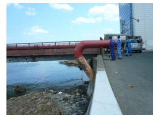
鋼管により応急復旧
