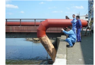
橋の歩道部に転がし配管
