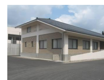
高台にある浄化センターは被害なし
