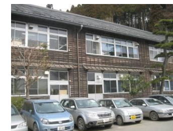
高台の市庁舎は津波の被害なし
