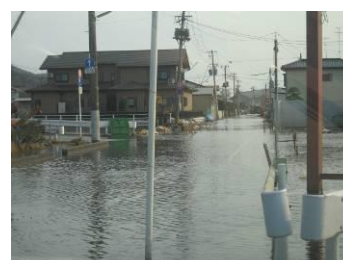
沿岸地域の一部は、地盤沈下により満潮時に浸水
