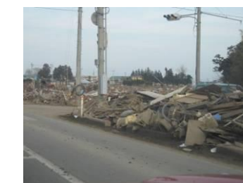
平地部の被災状況②
