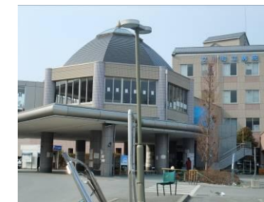
十数メートル高台にある病院も、津波により数メートル冠水した
