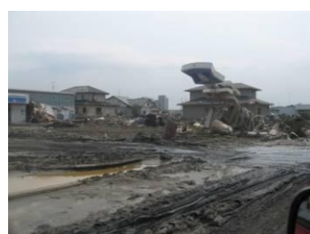
沿岸地域の被災状況②
