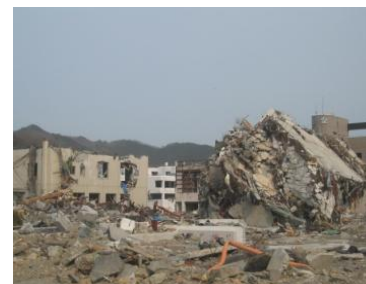
沿岸地域の被災状況②
