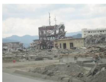
沿岸地域の被災状況①
