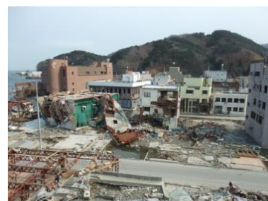
沿岸地域の被災状況①
