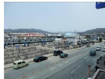
石巻駅の被害は軽微
