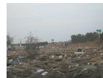
平地部の被災状況①
