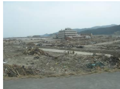
沿岸地域の被災状況①
