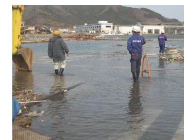
沿岸地域は地盤沈下により一部水没
