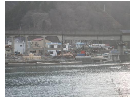
落下して漂着した水管橋（中央）
