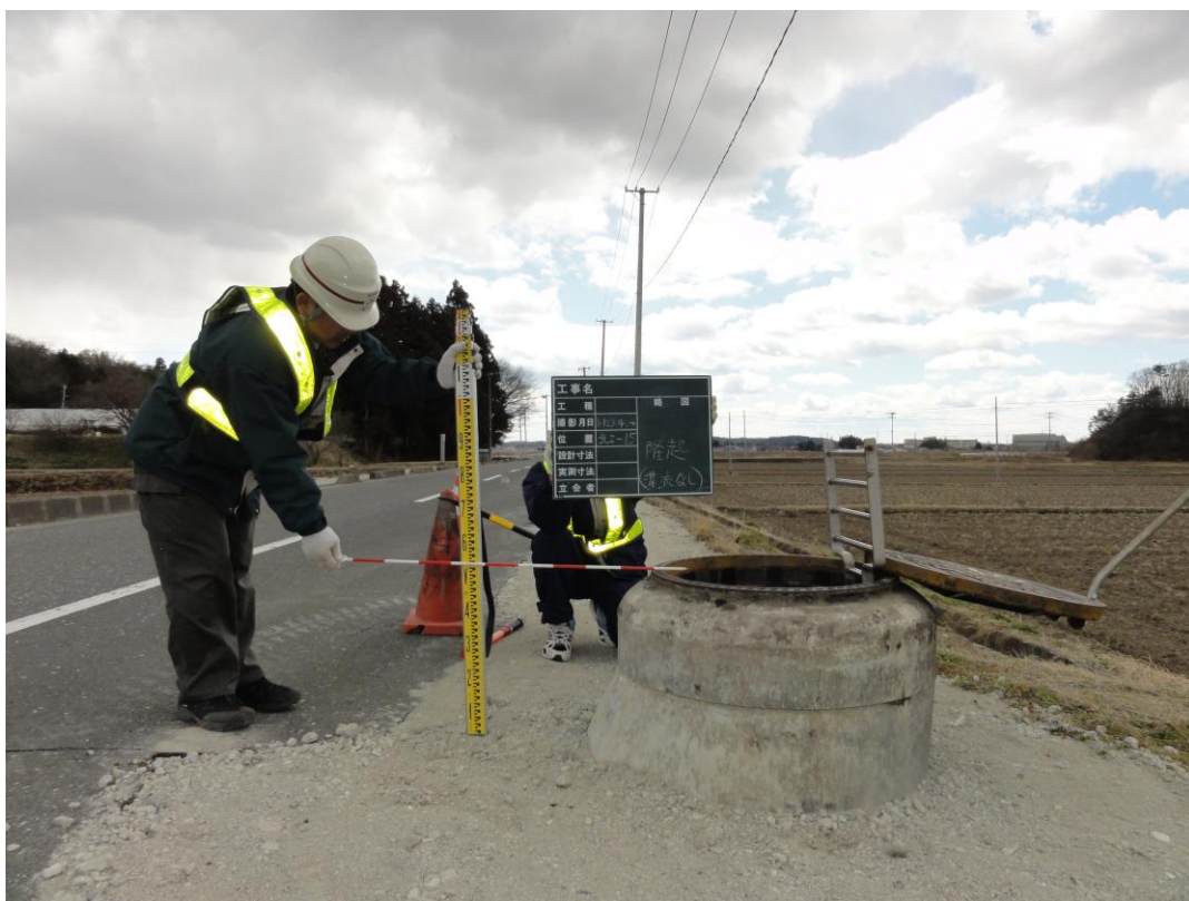
吉田川流域下水道 北部第二幹線 (マンホール隆起)
