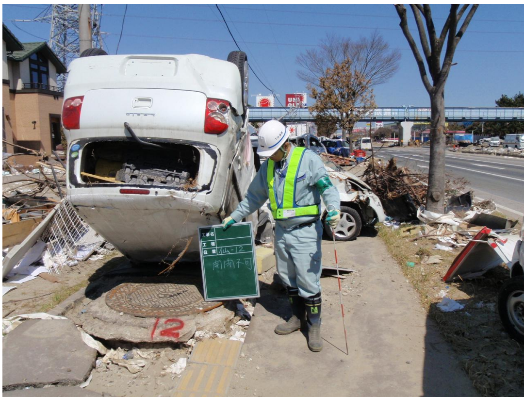
仙塩流域下水道 仙台幹線（マンホール開閉不可）
